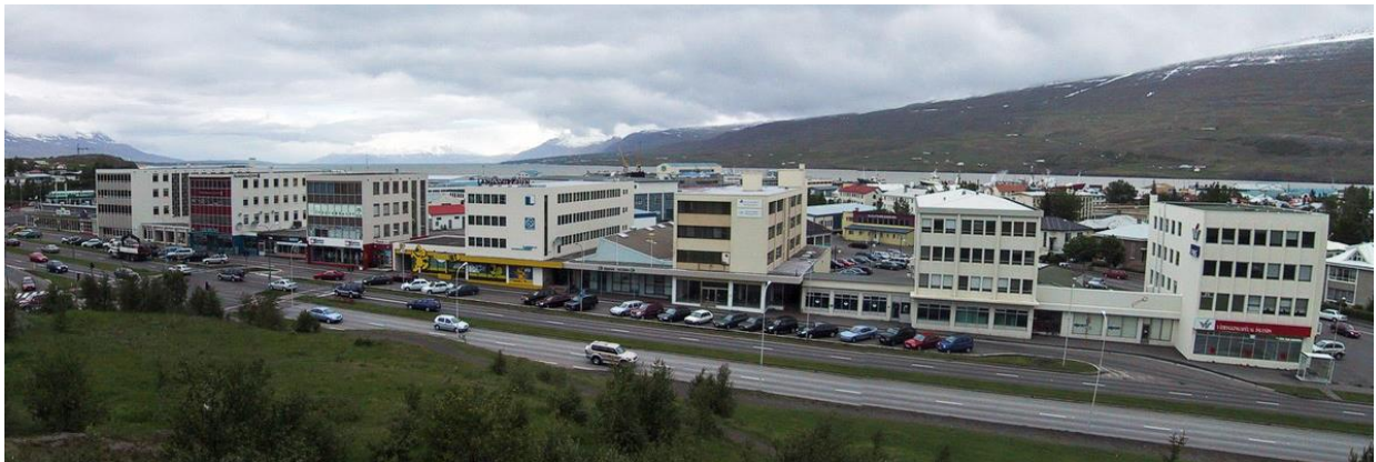
18. Mynd Húsaröðin við Glerárgötu 2002.
