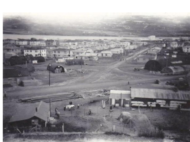
17. Mynd Gatnamót Glerárgötu, Hvannavalla og Eyrarvegur.
