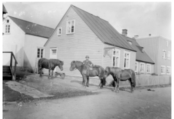
Húsið var einlyft með noður-suðurmæni fram til 1902.
