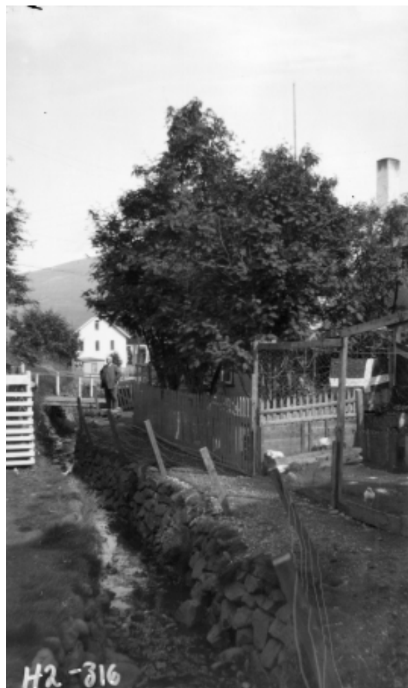
Lækjarfarvegurinn milli Ráðhússtígs og Aðalstrætis framan og sunnan við Aðalstræti 4. Lækjarbakkarnir voru hlaðnir úr grjóti og brú var yfir lækinn.
